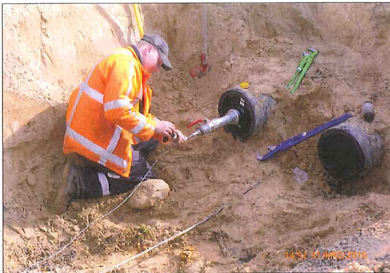
Bild 2: Leerrohre 355 mm Außendurchmesser
