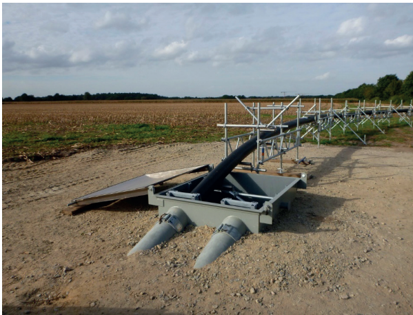
Bild 19.2 AGS-Technik zur reversiblen Verlegung von HV-Kabeln
